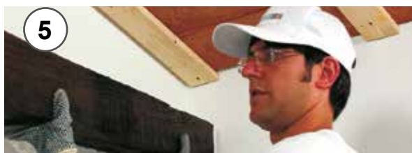
5 - Posizionamento trave 5 - Beam positioning.
