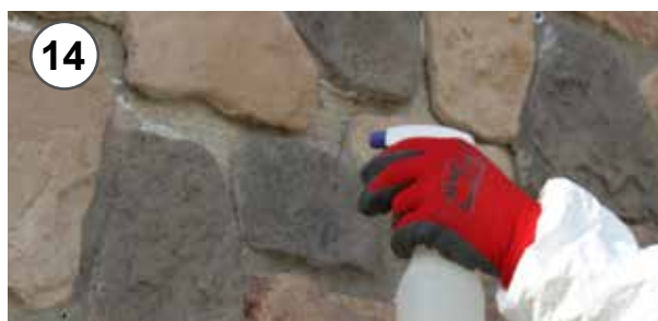
14 - Umidificazione del giunto con acqua nebulizzata prima dell'applicazione dello stucco 14 - Humidification of joint by water spray before grouting.
