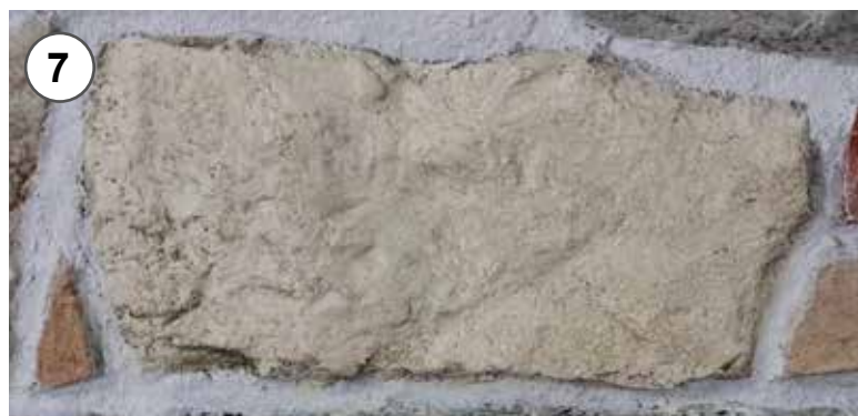
10 - Pietra ricostruita e lavoro ultimato 10 - The finished rebuiled stone
