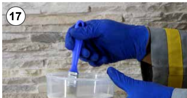
17 - Prima di ogni applicazione, mescolare con pennello, per mantenere gli ossidi in sospensione 17 - Before each application, mix by brush to keep oxides in suspension
