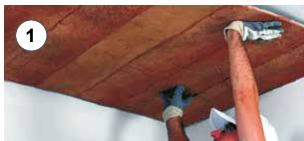
1 - Posizionamento pannello. 1 - Panel positioning.
