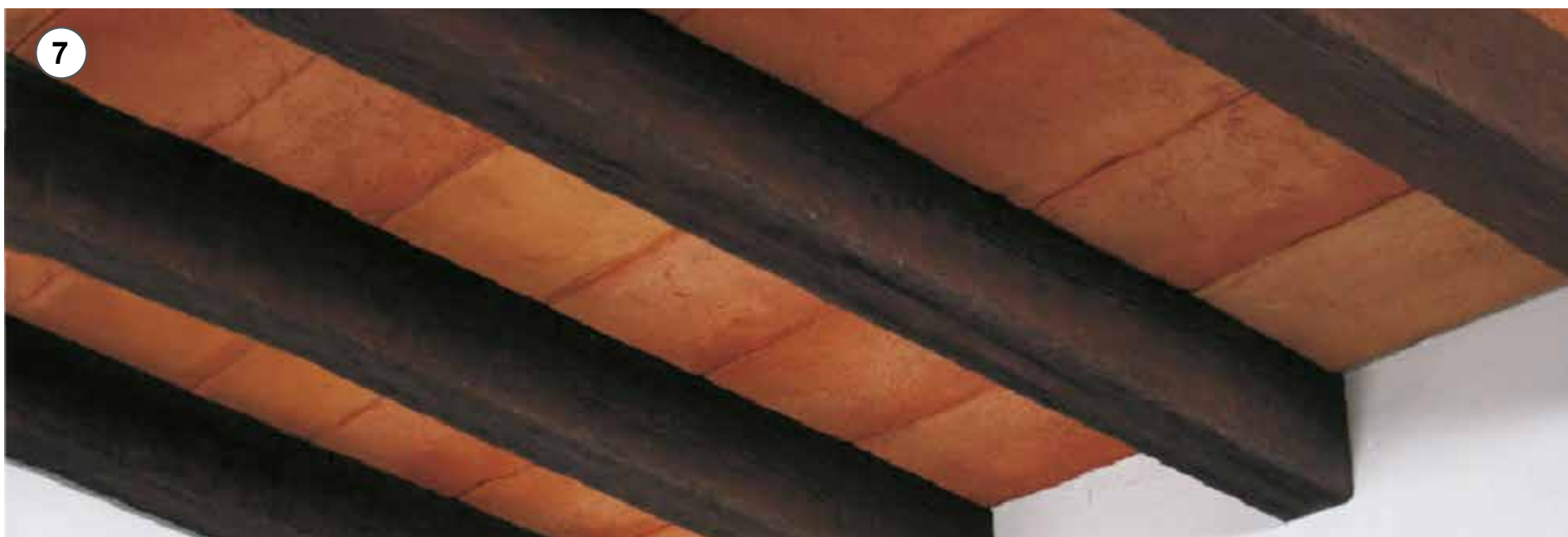
7 - Controsoffitto ultimato. 7 - Completed suspended-ceiling.
