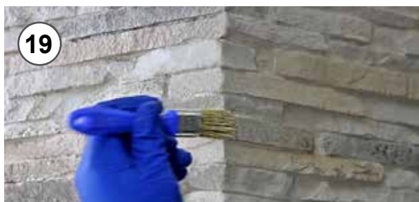
19 - Ossidatura pietra colore grigio 19 - Stone oxidizing by gray colour
