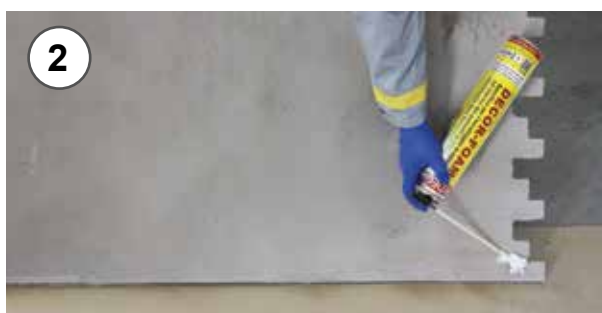
2 - Applicazione della schiuma poliuretanic 2 - Application of polyurethane foam
