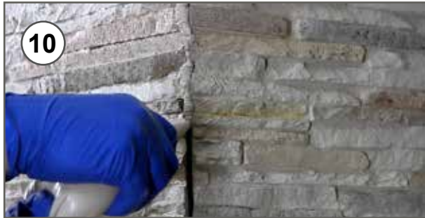
10 - Riempimento giunto con apposito stucco mediante "sac à poche" 10 - Fill joints with a filler using "sac à poche"
