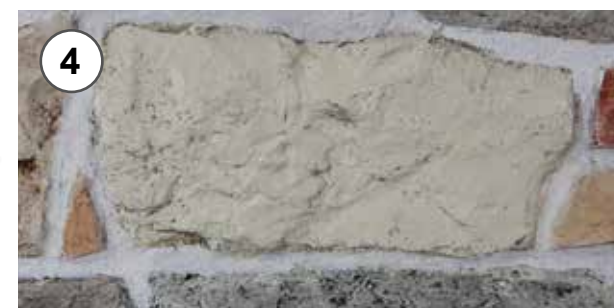
4- Pennellatura con stucco liquido della pietra ricostruita per uniformarne il colore di fondo 4 - Application of the glue on the wall
