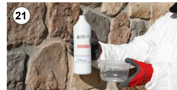
21 - Versare parte di ossido miscelato in un contenitore 21 - Pour the mixed oxide into a little container
