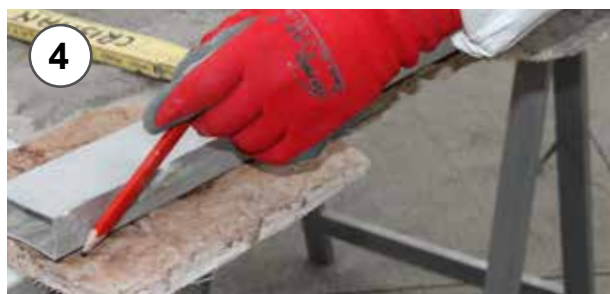
4 - Tracciatura dei pannelli 4 - Marking of panels
