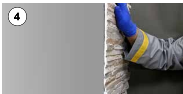
4 - Incollaggio del primo elemento angolo preventivamente tagliato a 45° 4 - Bonding of the first element previously cut angle at 45°
