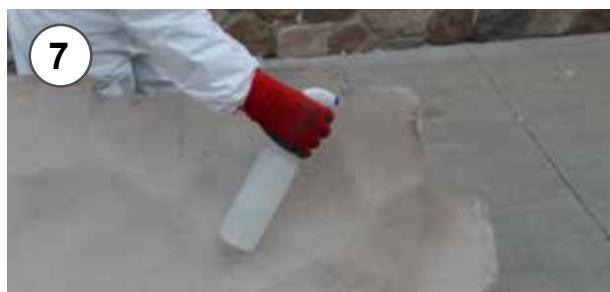
7 - Acqua nebulizzata sul retro del pannello per migliorare la presa 7 - Water spray on the back of the panel, to improve grip
