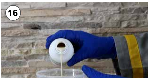
16 - Versare parte di ossido miscelato in un contenitore 16 - Pour the mixed oxide into a little container
