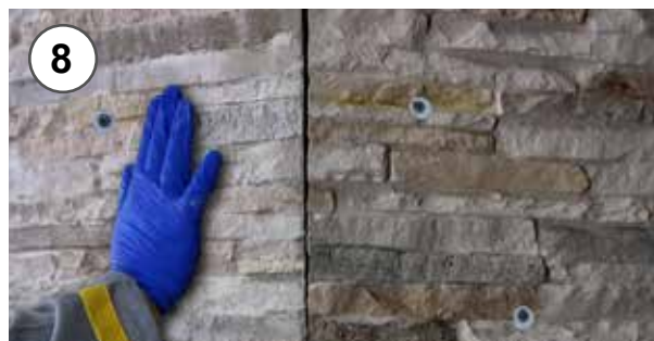
8 - Ad incollaggio ed indurimento avvenuto rimozione di viti e rondelle precedentemente posizionate 8 - On occurred glueing, removing screws and washers
