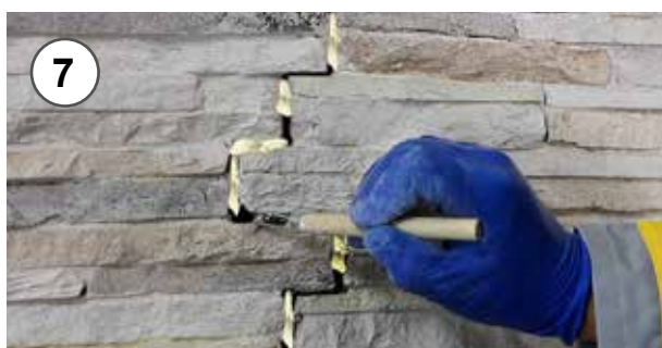
7 - Pulizia dei giunti dai residui di schiuma fuoriuscita 7 - Joints cleaning from foam residues
