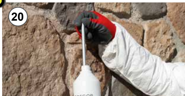
20 - Mescolare con asta metallica per rimuovere le parti solidificate sul fondo del contenitore! 20 - Mix, by metal bar, to remove solidified parts
