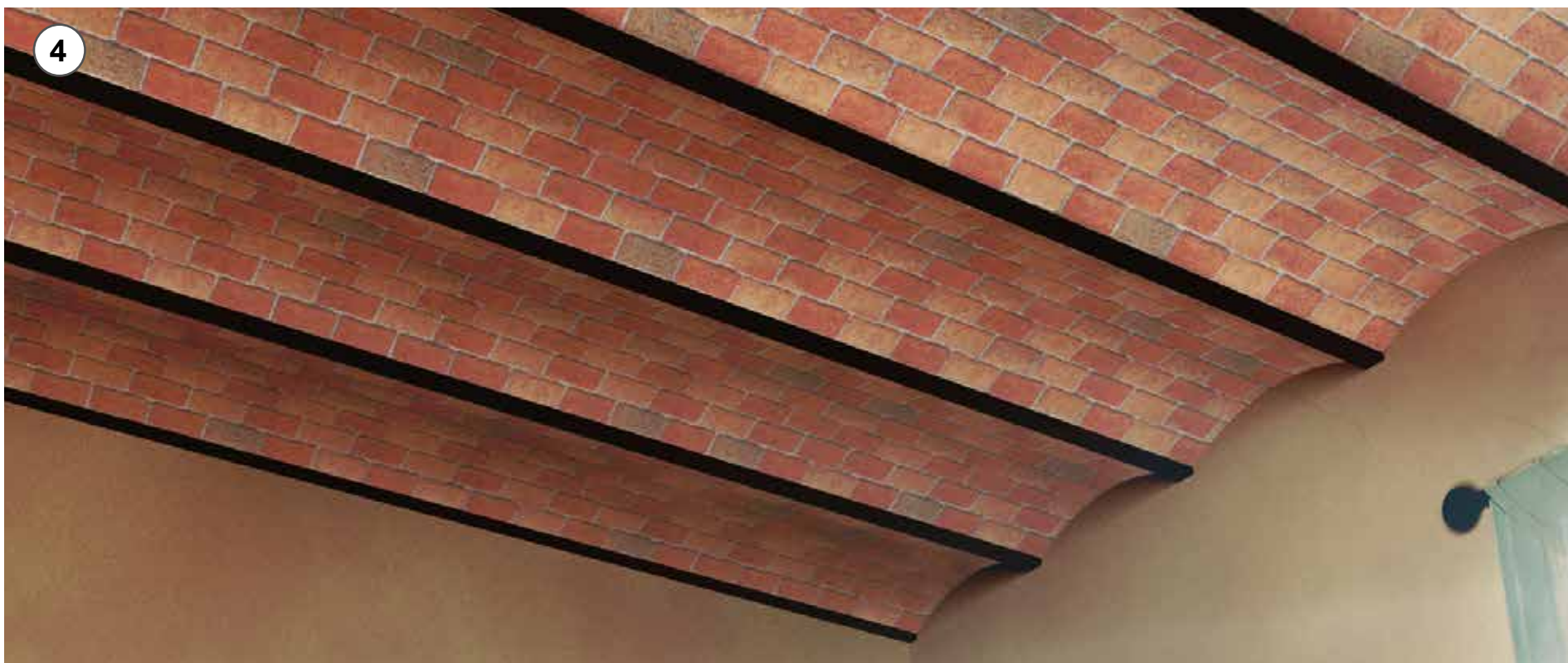
4 - Controsoffitto ultimato. 4 - Completed suspended-ceiling.
