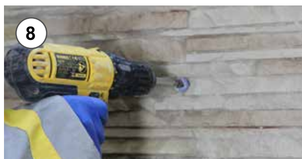
8 - Ad incollaggio avvenuto rimozione di viti e rondelle 8 - On occurred glueing, removing screws and washers
