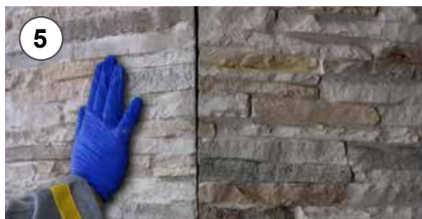
5 - Incollaggio del secondo elemento angolo preventivamente tagliato a 45° 5 - Bonding of the second element previously cut angle at 45°
