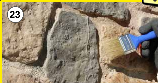
23 - Per ottenere una colorazione uniforme, oltre a colorare il giunto ricostruito, sfumare sui giunti adiacenti 23 - To obtain uniform coloring in addition to coloring the rebuilt joint fade out on the adjacent joints
