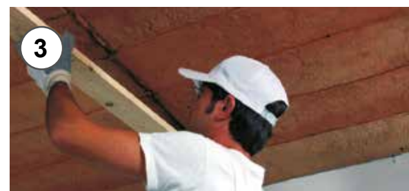
3 - Posizionamento listello in legno per fissaggio trave. 3 - Wooden lath positioning for beams fixing.
