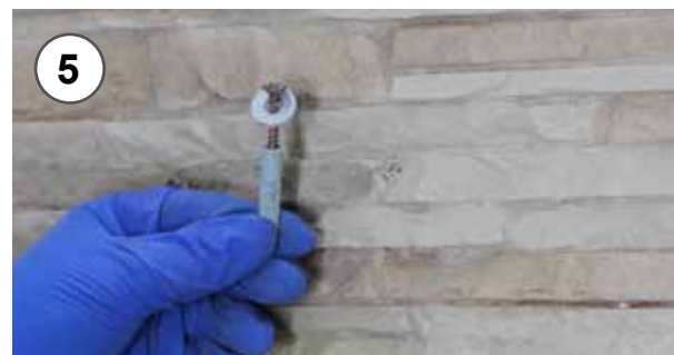
5 - Fissaggio meccanico provvisorio con viti e rondelle 5 - Temporary mechanical fastening by screws and washers
