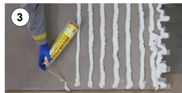
3 - Applicazione della schiuma poliuretanic distanziando le strisce di circa 10 cm 3 - Application of polyurethane foam spacing the strips of about 10 cm
