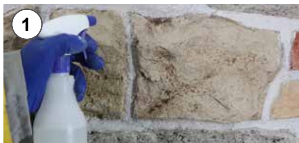
1- Inumidire con apposito nebulizzatore 1 - Application of the glue on the wall
