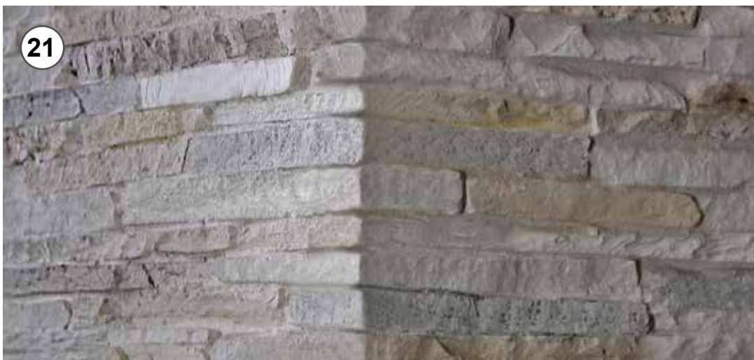
21 - Angolo ricostruito e finitura completata 21 - Rebuilt angle and complete finish
