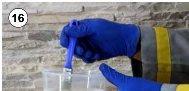
16 - Prima di ogni applicazione, mescolare con pennello per mantenere gli ossidi in sospensione 16 - Before each application, mix by brush to keep oxides in suspension
