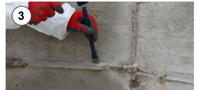
3 - Eliminazione delle imperfezioni 3 - Removal of imperfections
