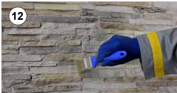
12 - Pulitura del giunto con pennello asciutto 12 - Cleanup the joint with a dry brush
