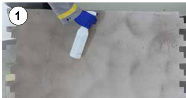
1 - Acqua nebulizzata sul retro del pannello per migliorare la presa 1 - Water spray on the back of the panel to improve grip
