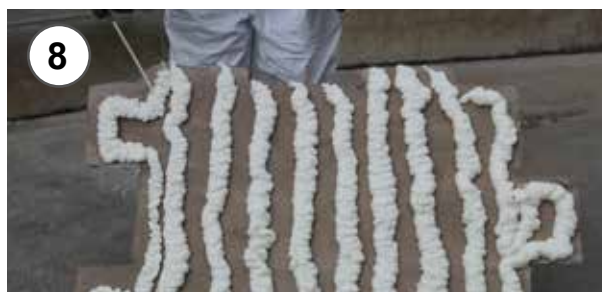
8 - Applicazione della schiuma poliuretanica distanziando le strisce di circa 10 cm 8 - Application of polyurethane foam spacing the strips of about 10 cm
