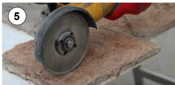
5 - Taglio dei pannelli mediante smerigliatrice 5 - Cutting of panels using the Flex
