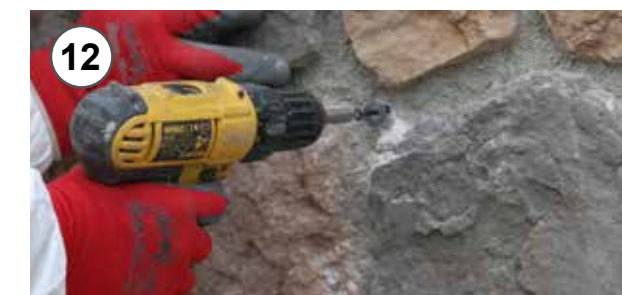
12 - Ad incollaggio avvenuto, rimozione di viti e rondelle precedentemente posizionate 12 - On occurred glueing, removing screws and washers previously positioned
