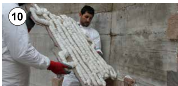
10 - Applicazione del pannello sulla parete con leggera pressione 10 - Applying of panel on the wall with light pressure
