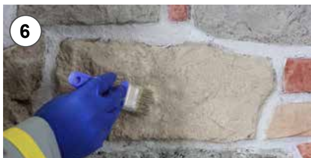
9 - Ossidatura della pietra ricostruita da effettuare a completa asciugatura dello stucco utilizzato per la ricostruzione 9 - Oxidize the stone with a small brush to be made completely at glue dry used for reconstruction
