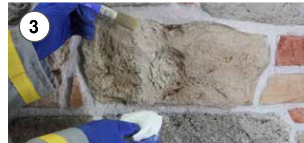
3- Modellatura dello stucco con pennello e carta assorbente 3 - Application of the glue on the wall
