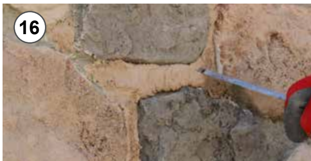
16 - A parziale essiccazione avvenuta dello stucco rifinire il giunto con utensile 16 - At partial drying of the grout, finish the joint by tool
