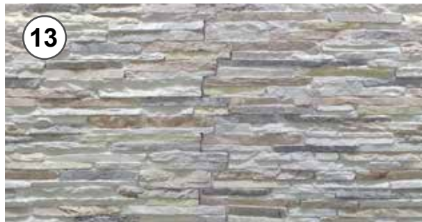
13 - Giunto pronto per l'applicazione degli ossidi coloranti da effet- tuarsi a totale essiccazione dello stucco 13 - Joint ready for the application of colored oxides after total drying of the grout
